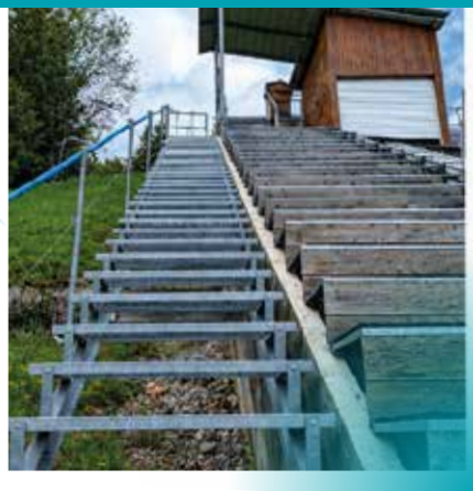
Escalier vers le sommet des tremplins K90
